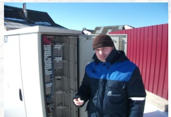
Электромонтер Козлов А.Л. кроссирует абонента на ТКШ.
