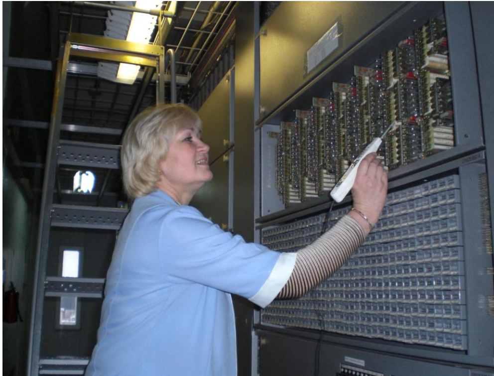
Производятся профилактические работы оборудования Пентаконта. Инженер АТС-23 Тесовец Г.Н.
