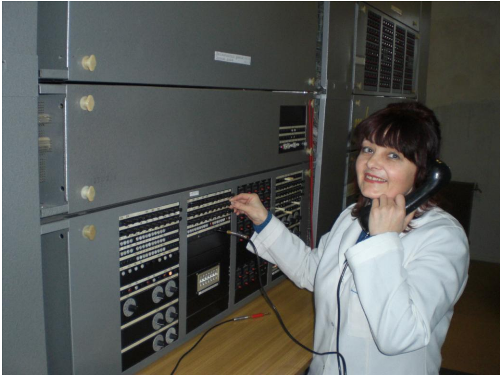
Электромеханик АТС-23 Михалкович В.Н. производит проверку оборудования Пентаконта.
