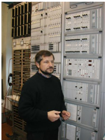
Инженер Крижевский И. А. в зале телеграфного оборудования.
