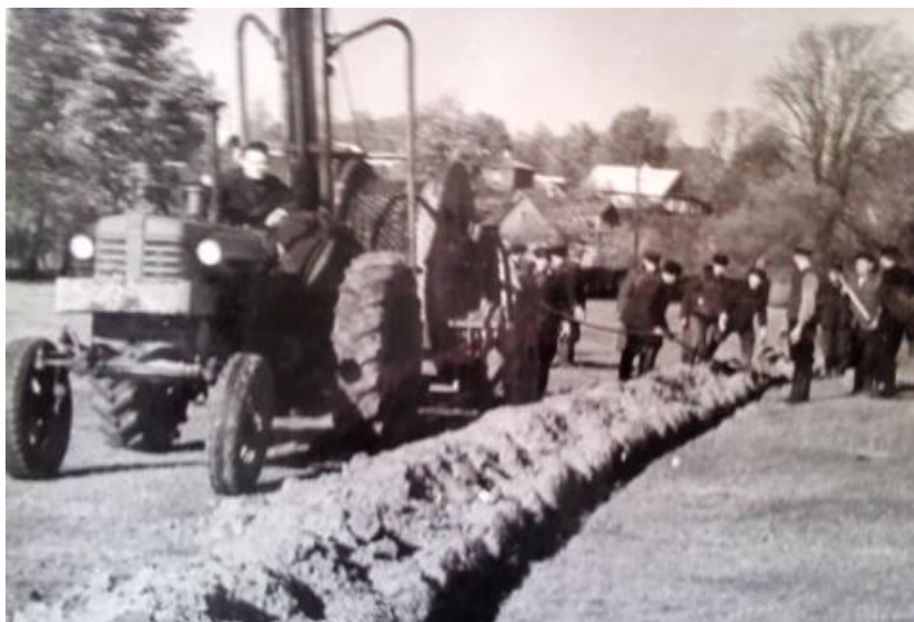
Прокладка междугороднего кабеля.
