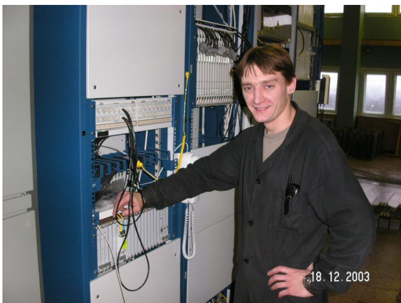
Инженер Галынский С. Г. на подключении оборудования FK-35. 2003 год.
