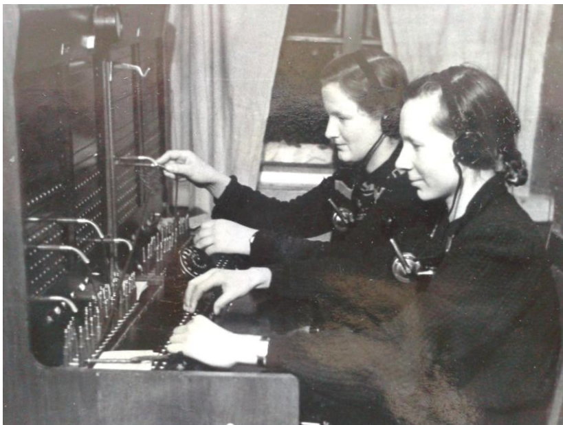
Телефонная станция ЦБ на 200 номеров. 1959 год.
