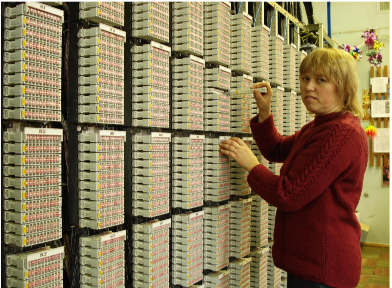
Введена электронная АТС-205 (типа АТСЭ ФМ) на **360** (взамен АТСК-50/200) с последующим расширением до **512** номеров.
