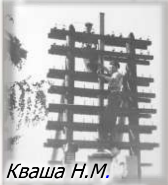
Клецкий РУС Строительство ВЛС
